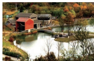
汤山温泉旅游度假区大凹村 片区环境提升工程
