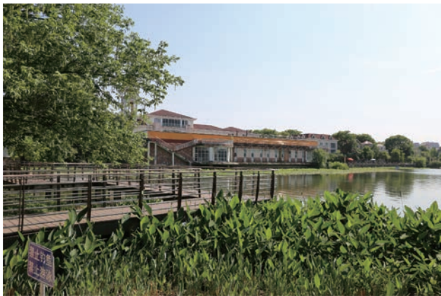
图1 改造过的河道景观
