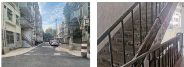
图1 小区建筑外立面、楼梯等现状
