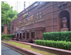
上海徐汇苑养护项目
