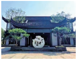
海门鸿麦家园古建项目
